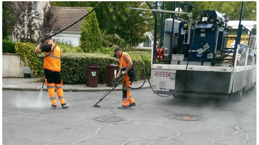
Les 21 et 22 août dernier, la plupart des rues des Lilandry ont reçu le traitement nécessaire au colmatage des fissures provoquées par le temps qui passe et le sel de déneigement.
