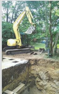
Cette intervention sera suivie s'une fouille **nécessaire au repérage de la canalisation**. Puis celle-ci sera recouverte et protégée jusqu'au mois d'octobre 2014, date à laquelle la canalisation étudiée, commandée et éprouvée, sera livrée pour être installée dans la fouille. Pendant la durée des travaux, **le cheminement sera possible et un passage piéton d'un mètre sera établi**. GRT GAZ vous prie de bien vouloir l'excuser de la gêne occasionnée, nécessaire à l'amélioration de votre confort.
